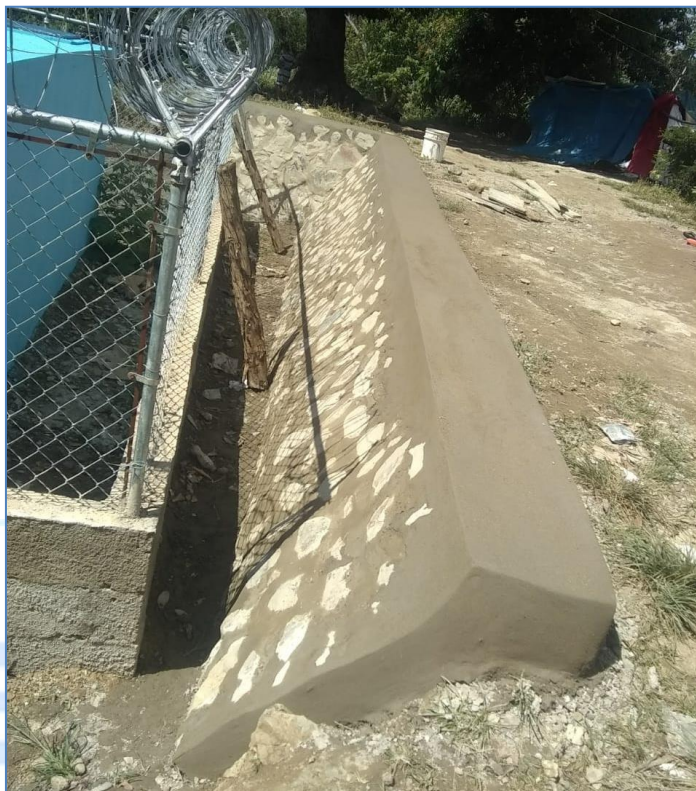
Terminación del encache en muro, Solución Agua Potable Vista Hermosa.
