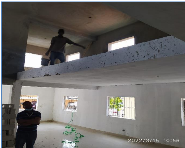
Aplicación de pintura en interior, Terminación asociación estudiantes Cambita.
