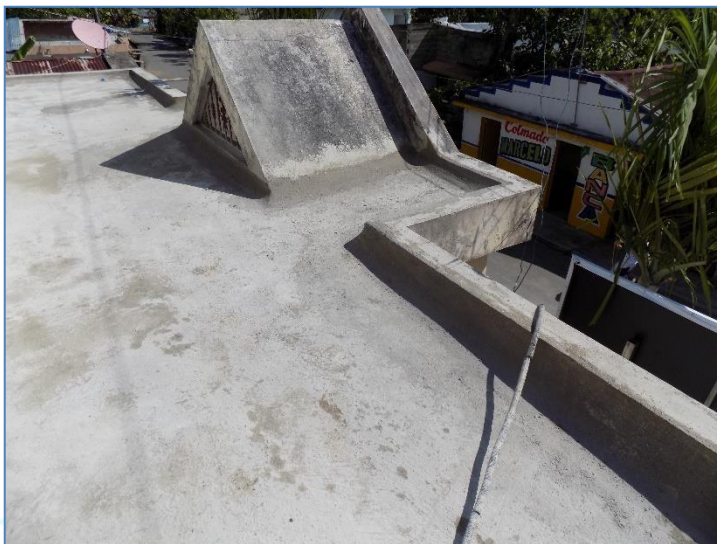
Colocación de fino de techo, Reparación Centro Comunal Arroyo Toro.
