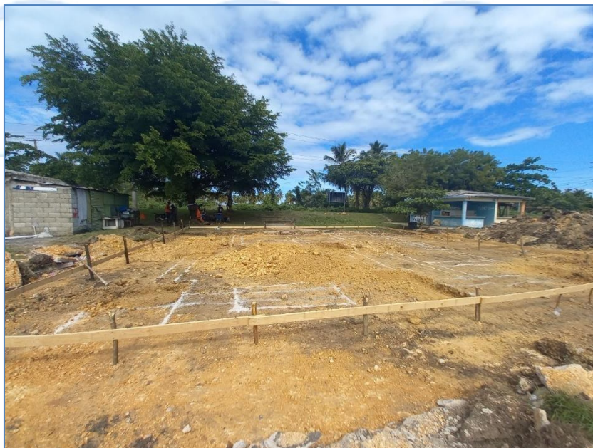
Charrancho y replanteo de cimientos, Destacamento Militar Matancitas.
