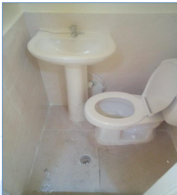
Instalación de aparatos sanitarios, Centro Médico Las Palmitas.
