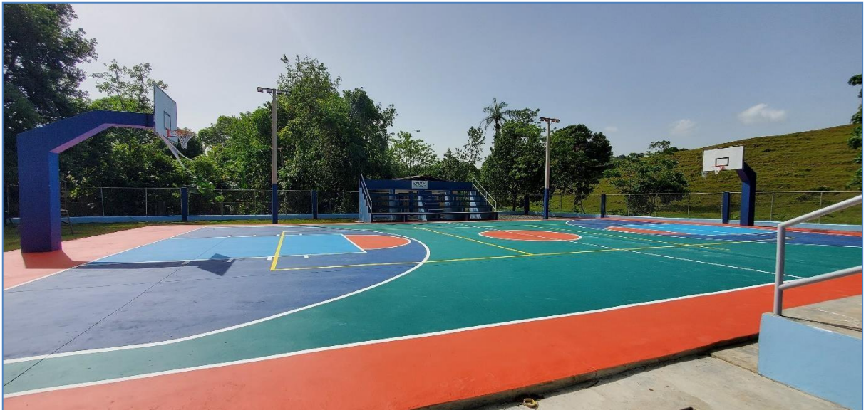
Área de juego cancha de baloncesto, Reparación Cancha Club la Salvia-Los Quemados.
