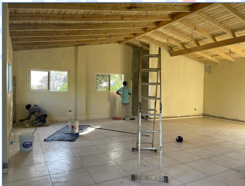
Pisos y techo de madera segundo nivel, Salón comunal Los Capacitos
