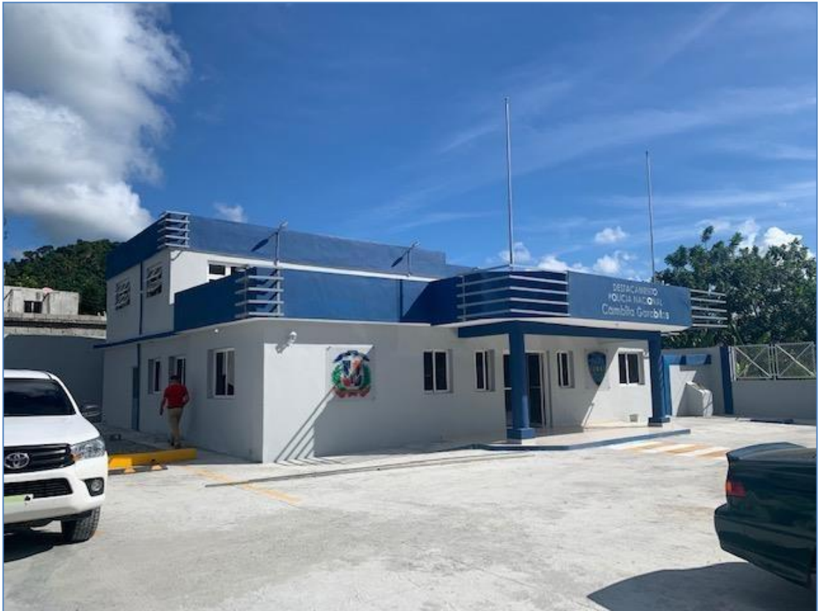
Vista General, Destacamento Cambita.
