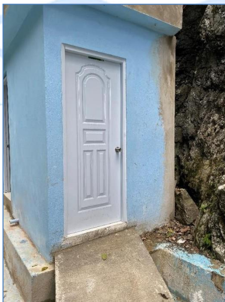
Baño para empleados, Central Hidroeléctrica Jimenoa.
