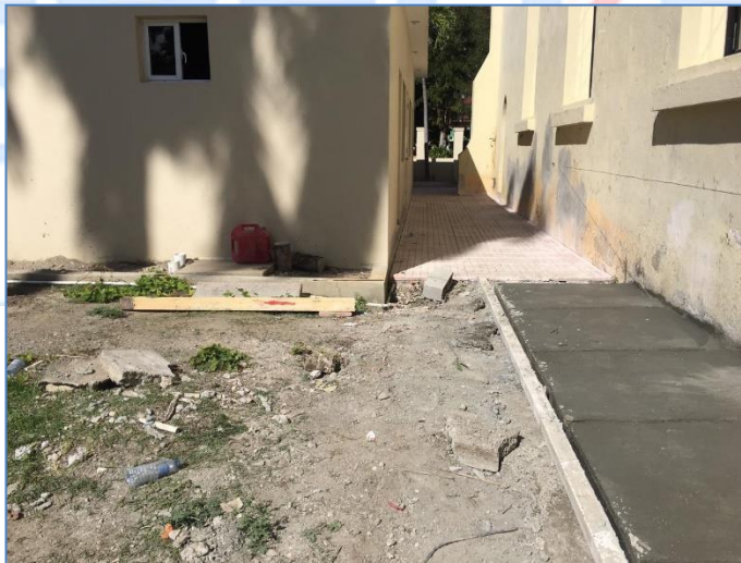
Construcción de acera, Iglesia Santa Lucía.
