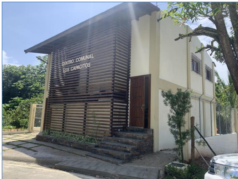
Fachada, Salón comunal Los Capacitos.
