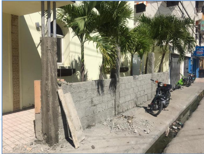
Construcción verja posterior, Iglesia Santa Lucía.
