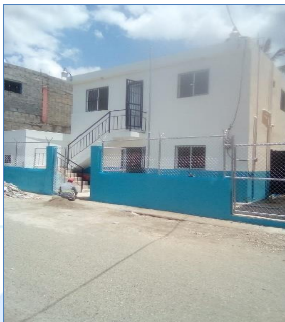
Aplicación de pintura en exterior, Centro Médico Las Palmitas.
