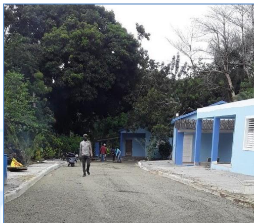
Imprimación calles internas campamento, Central Hidroeléctrica Jimenoa.
