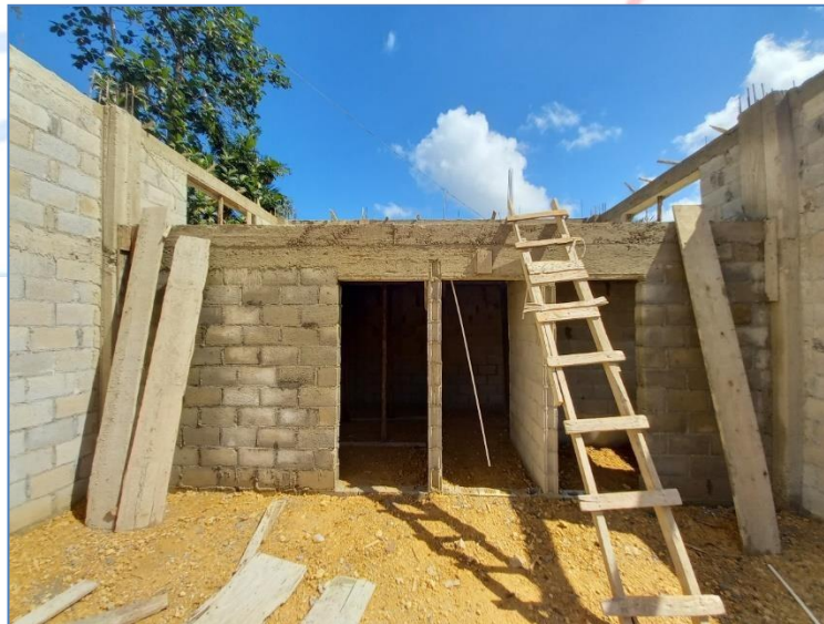
Desencofrado de losa de oficinas en almacén, Construcciones varias C.H. Rosa Julia de la Cruz.
