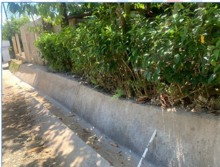
Construcción de canaleta, Reparación Centro Comunal Arroyo Toro.
