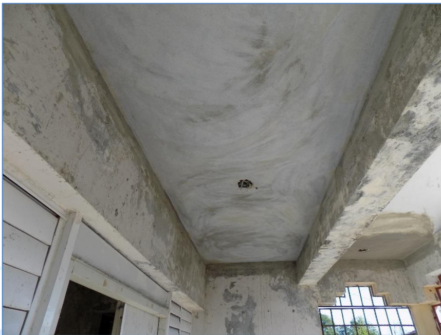
Colocación pañete de techo, Reparación Centro Comunal Arroyo Toro
