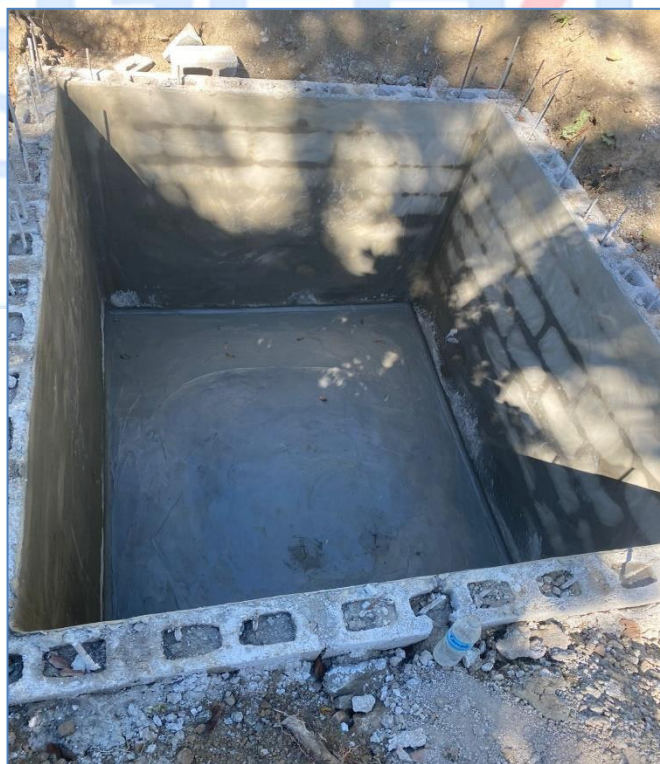
Colocación de bloques en cámara séptica, Terminación capilla de Fátima.
