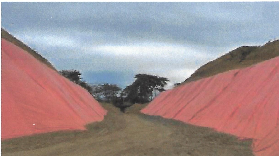
Instalación lona protectora de Talud en Canal de Desvío
