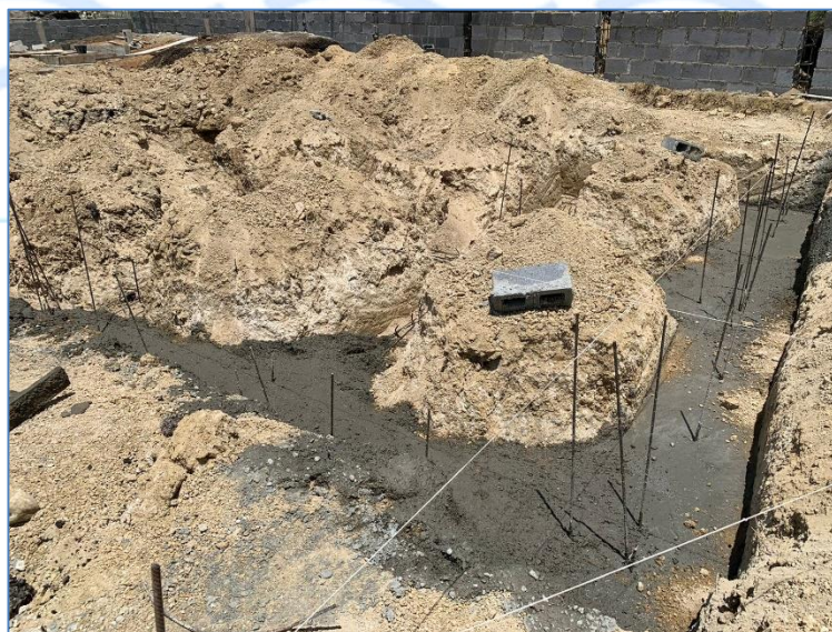
Vaciado de zapata en graderías, Cancha Ingenio Nuevo.
