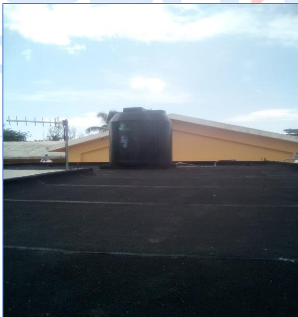
Colocación de lona asfáltica en techo, Centro Médico Las Palmitas.
