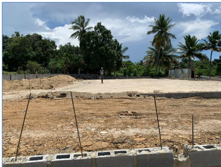
Compactación de relleno en área de juego, Cancha Ingenio Nuevo.
