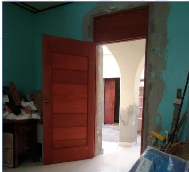
Instalación de puerta en madera, Iglesia Santa Lucía.
