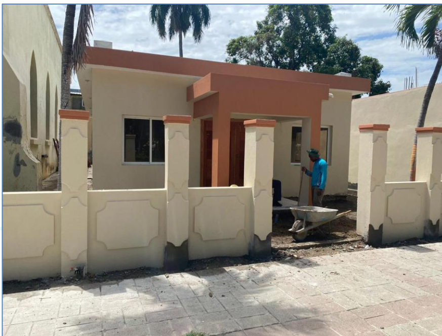
Aplicación de pintura en exterior salón multiusos y verja frontal, Iglesia Santa Lucía.
