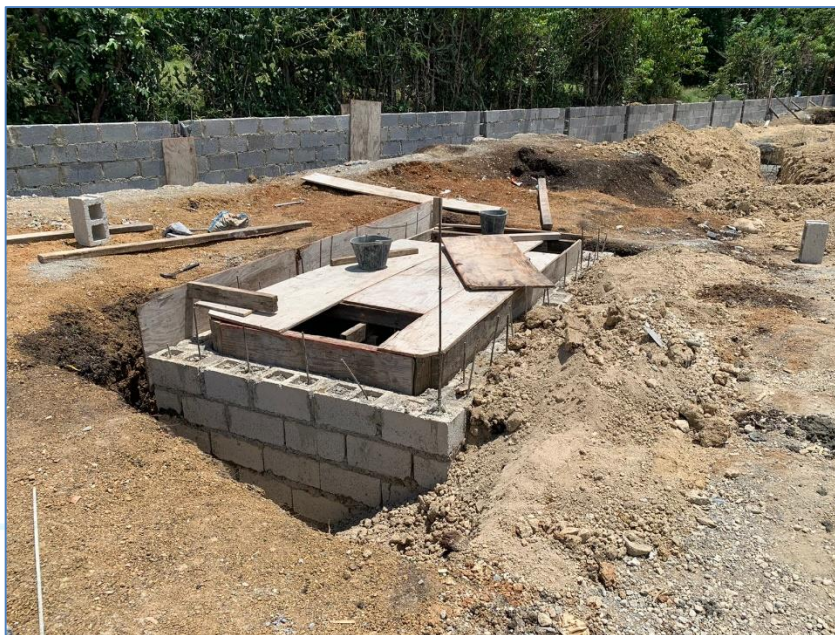
Encofrado de losa de techo de cisterna, Cancha Ingenio Nuevo.
