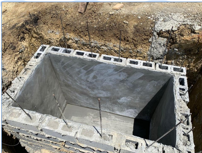
Pañete de muros interiores de séptico, Cancha Ingenio Nuevo.
