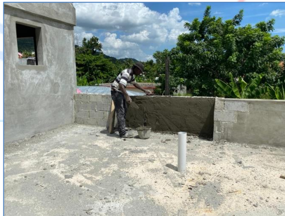
Colocación de pañete en antepecho, Destacamento Cambita.
