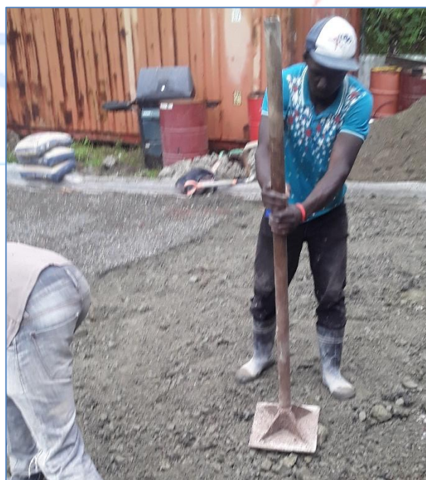
Vaciado de rampa entrada de almacén, Central Hidroeléctrica Jimenoa.
