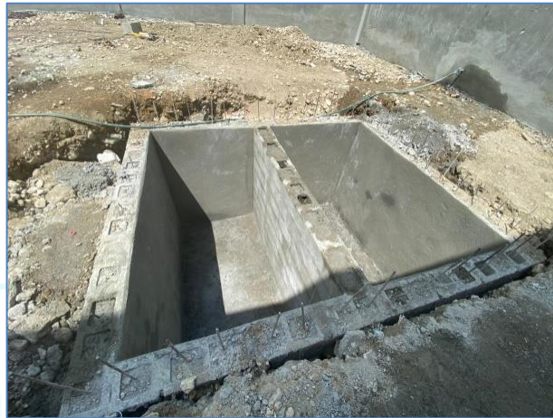
Colocación de pañete en interior de cámara séptica, Destacamento Cambita.
