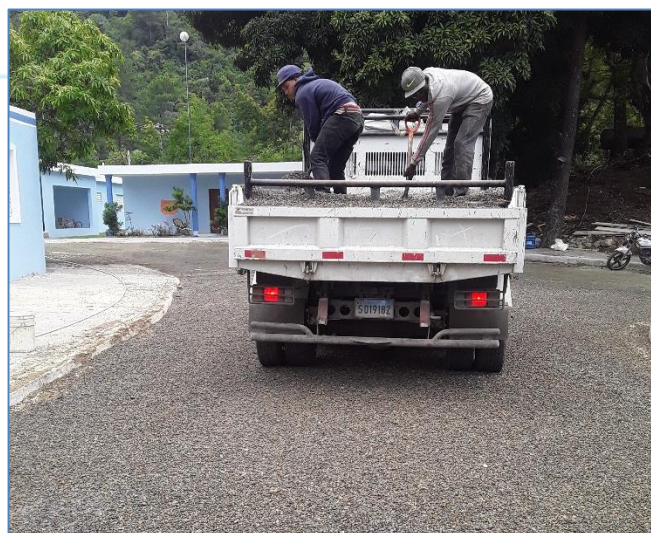
Imprimación calles internas campamento, Central Hidroeléctrica Jimenoa.
