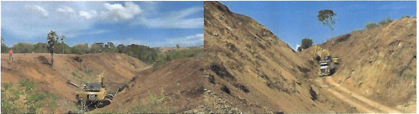
Despeje y desraizado Dique de cierre
