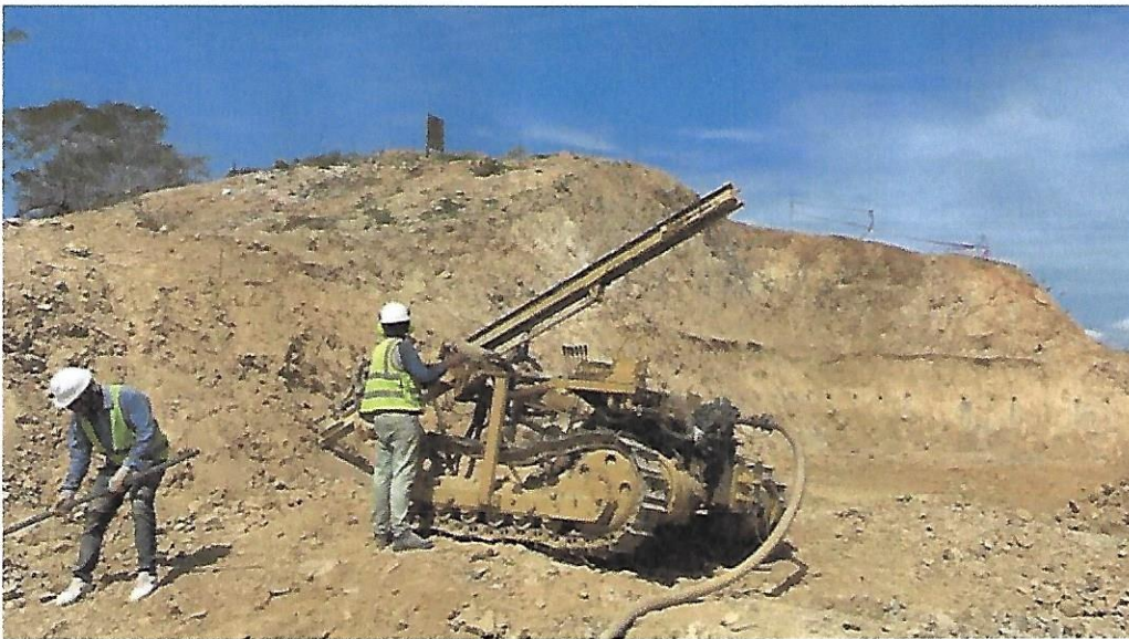
Perforación e instalación de pernos Presa Margen izquierda
