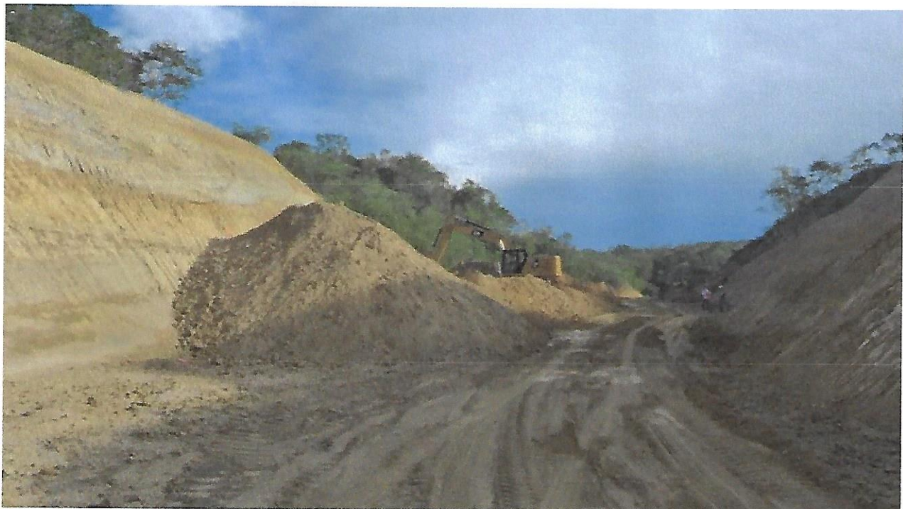
Excavación Etapa I, Estructura de Disipación
