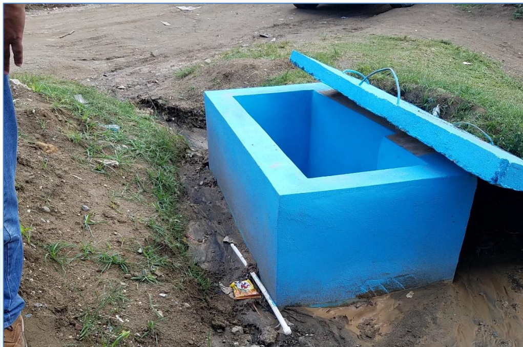
Construcción de registro para la bomba en el pozo, Solución Agua Potable Vista Hermosa.
