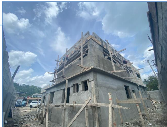
Pañete en exterior, Destacamento Cambita.
