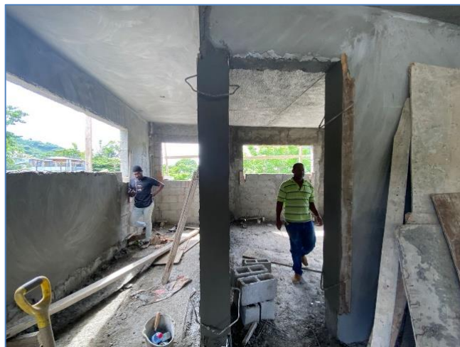
Colocación de pañete y electricidad 2do. nivel, Destacamento Cambita.
