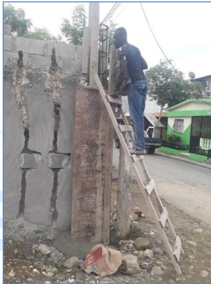
Vaciado vigas y columnas en verja perimetral, Destacamento Cambita.
