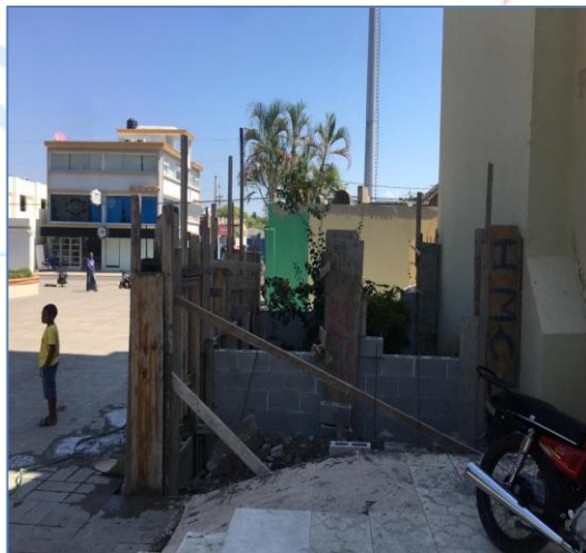
Construcción de verja lateral, Iglesia Santa Lucía.
