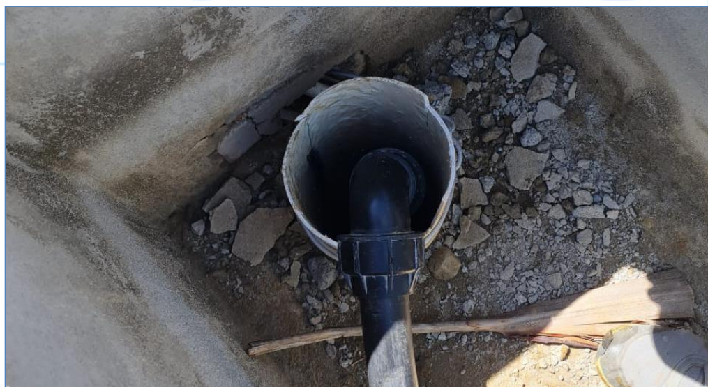
Instalación de bomba sumergible, Solución Agua Potable Vista Hermosa.
