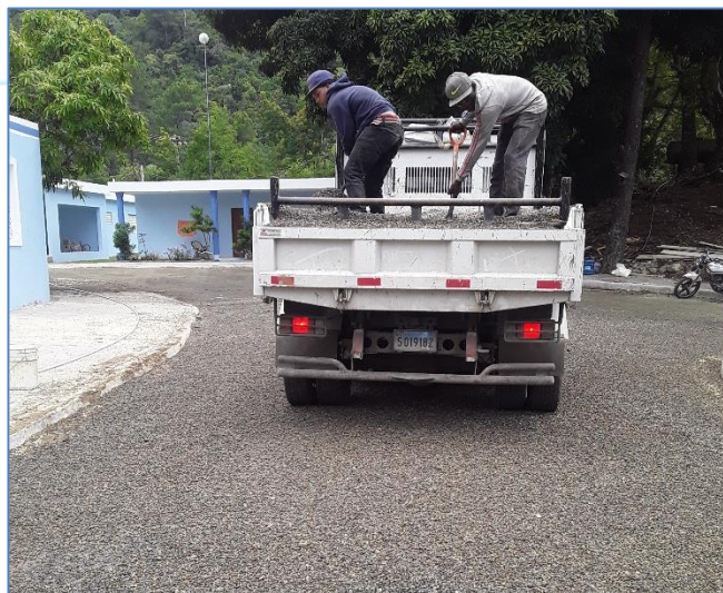
Imprimación calles internas campamento, Central Hidroeléctrica Jimenoa.
