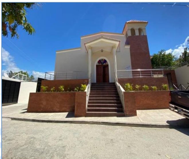
Fachada, Iglesia Perpetuo Socorro.
