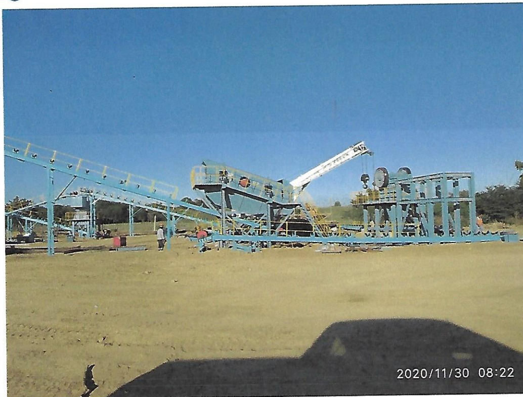
Vista Equipos de Plantas Industriales
