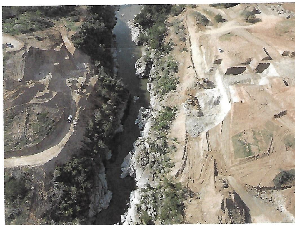
Vista Excavación estribo izquierdo y estribo derecho presa.
