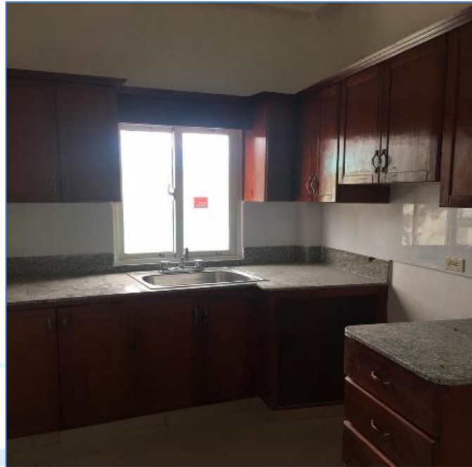
Instalación de gabinetes de cocina, Alcaldía Juan de Herrera.
