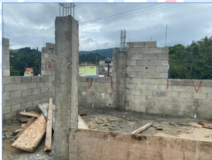
Vaciado de columnas 2do Nivel, Destacamento Cambita.
