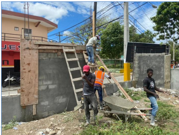
Vaciado de viga en verja perimetral, Destacamento Cambita.
