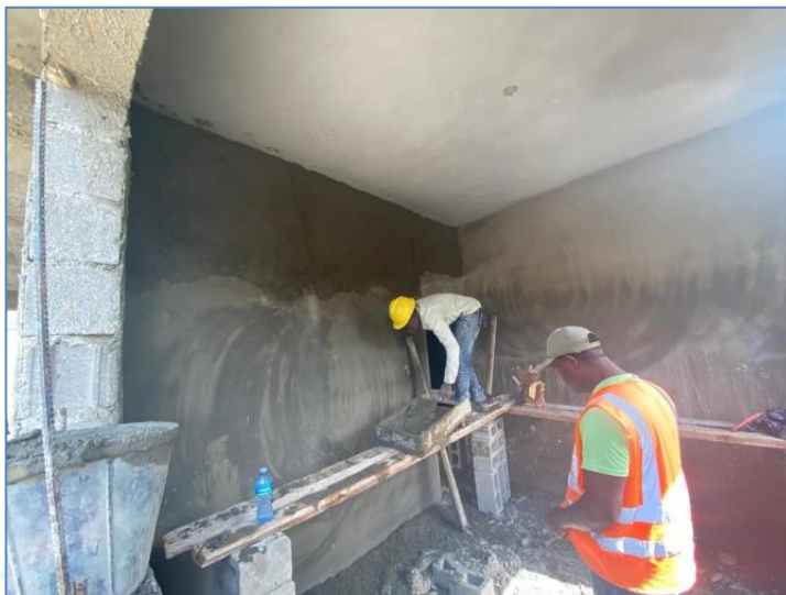
Colocación de pañete en interior, Destacamento Cambita.
