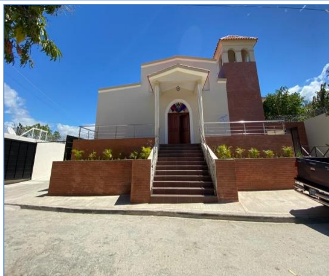
Fachada, Iglesia Perpetuo Socorro.
