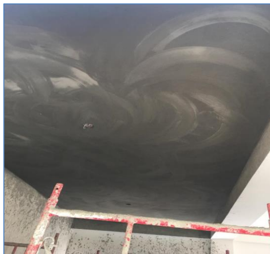
Terminación de pañete en techos, Iglesia Santa Lucía.
