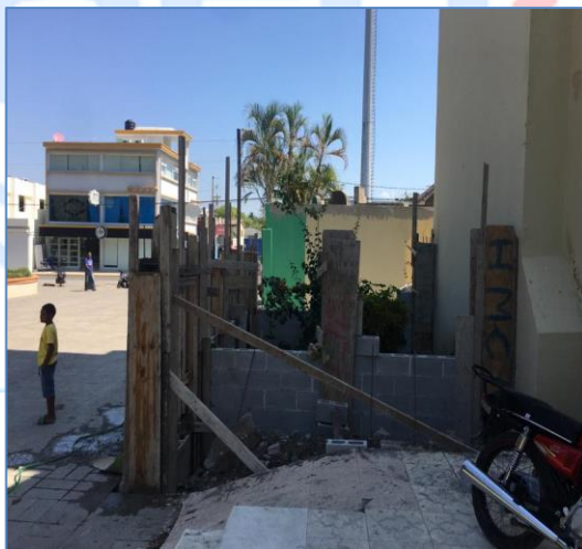
Construcción de verja lateral, Iglesia Santa Lucía.
