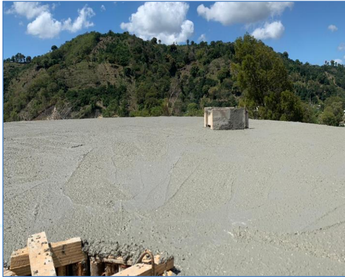
Vaciado de losa de techo en tanque los Jovitos, Acueducto Montería.
