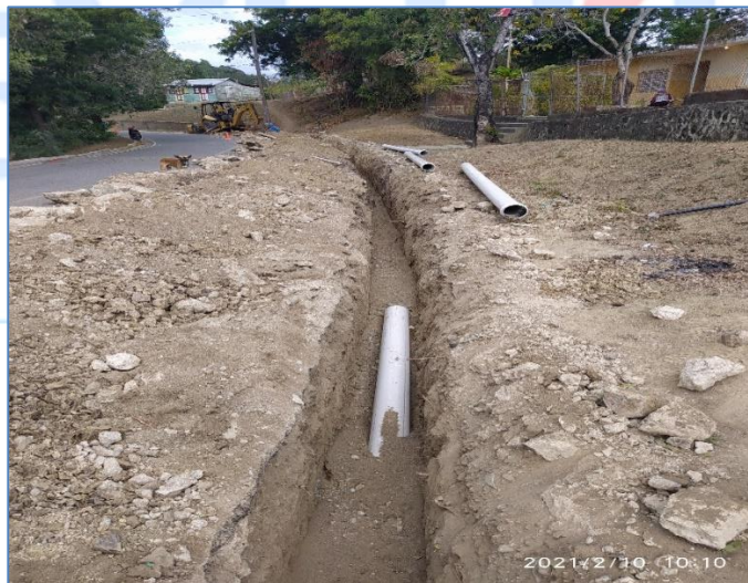
Colocación de línea de distribución PVC de 6", Acueducto Montería.
