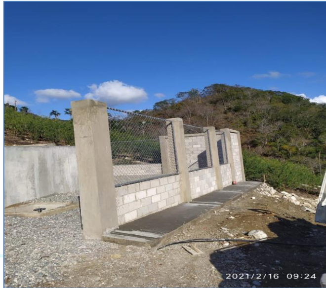
Vaciado de acera frontal en área de tanque de 500 m 3 , Acueducto Montería.
