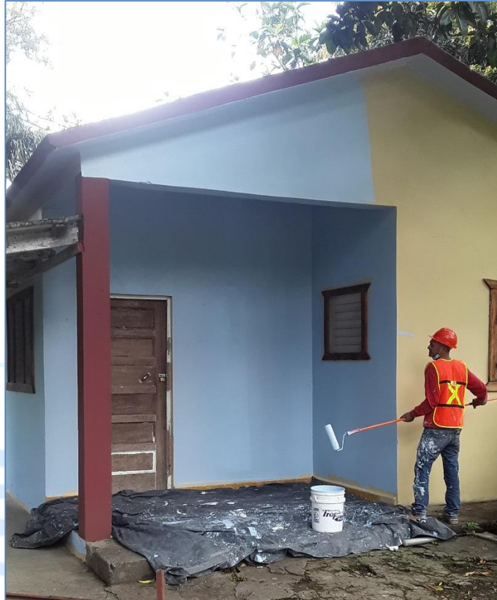
Aplicación pintura en exterior en casas existentes, Central Hidroeléctrica Jimenoa.
