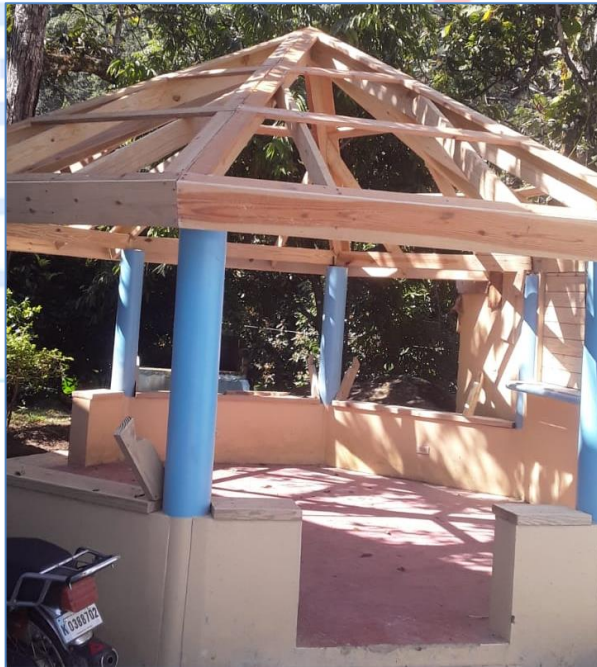
Estructura de techo de madera en Gazebo, Central Hidroeléctrica Jimenoa.
