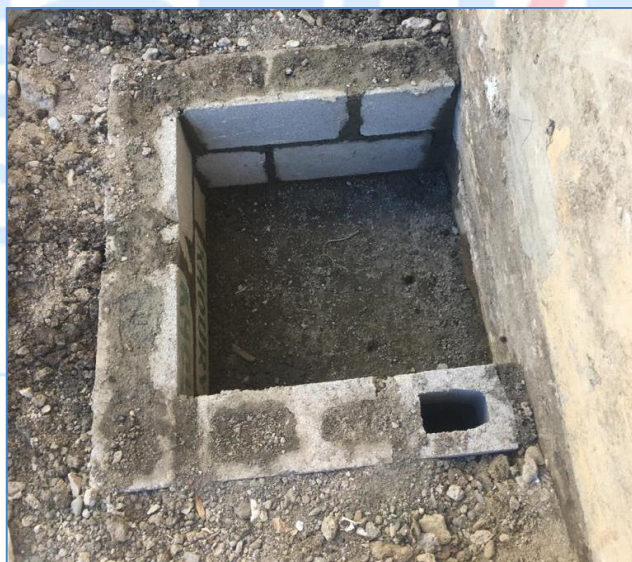
Construcción de registro sanitario, Iglesia Santa Lucía.
