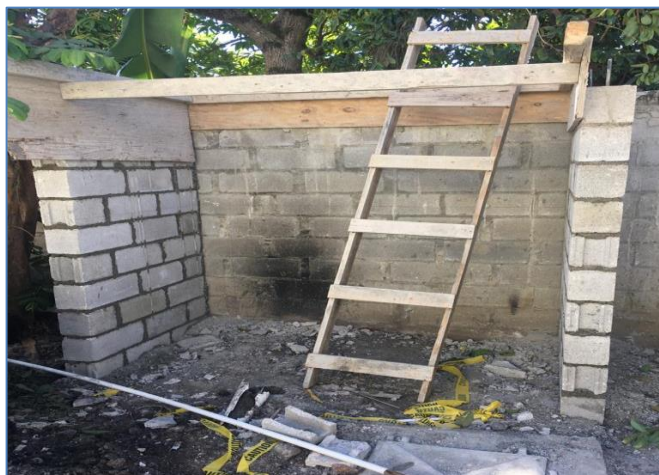
Colocación de bloques en caseta de bomba, Iglesia Santa Lucía.
