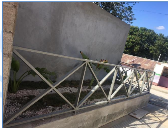
Instalación de barandas, Iglesia Perpetuo Socorro.
