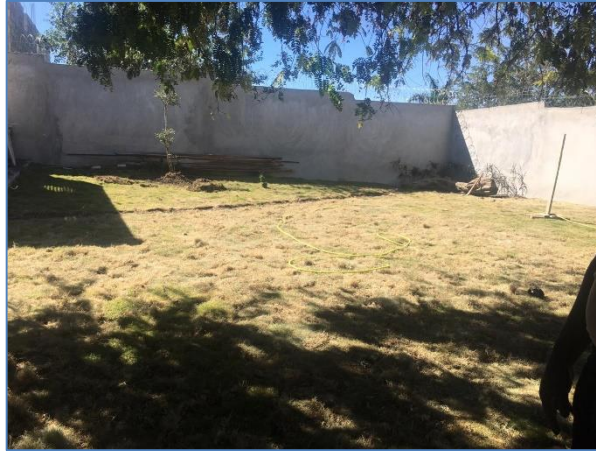
Colocación de grama, Iglesia Perpetuo Socorro.
