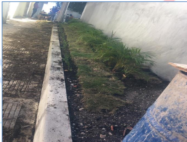
Colocación de gramas y plantas en área de jardineras, Iglesia Perpetuo Socorro.
