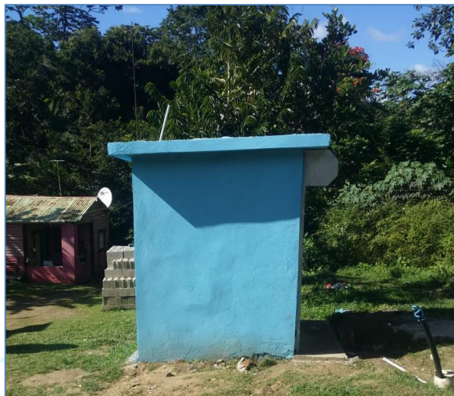
Aplicación de pintura en caseta para arrancador de la bomba, Solución Agua Potable Vista Hermosa.
