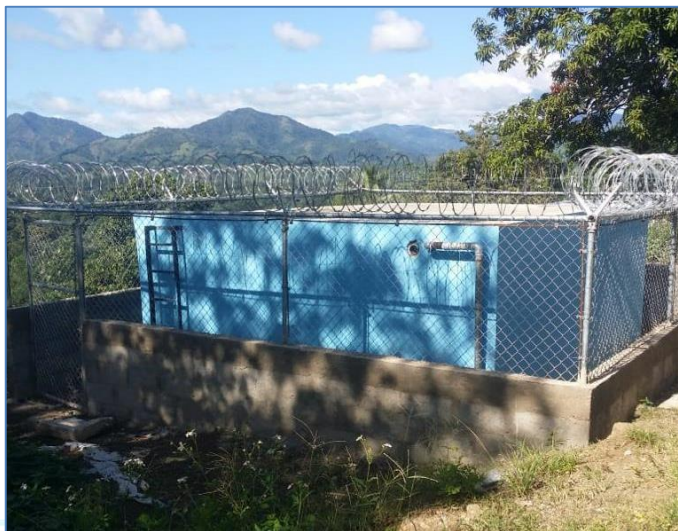
Aplicación de pintura en tanque de almacenamiento, Solución Agua Potable Vista Hermosa.
