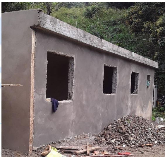
Colocación de pañete en casas, Campamento Jimenoa.
