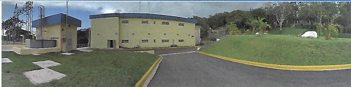
Vista general de la Expansión Central Hatillo.
