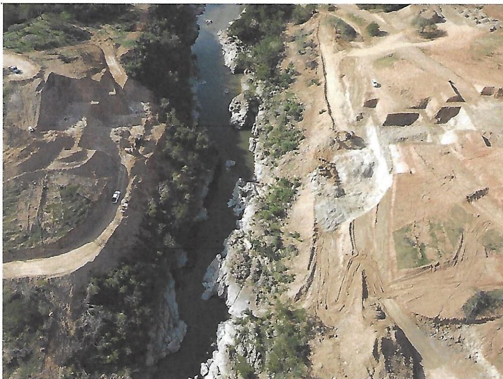
Vista Excavación estribo izquierdo y estribo derecho presa
