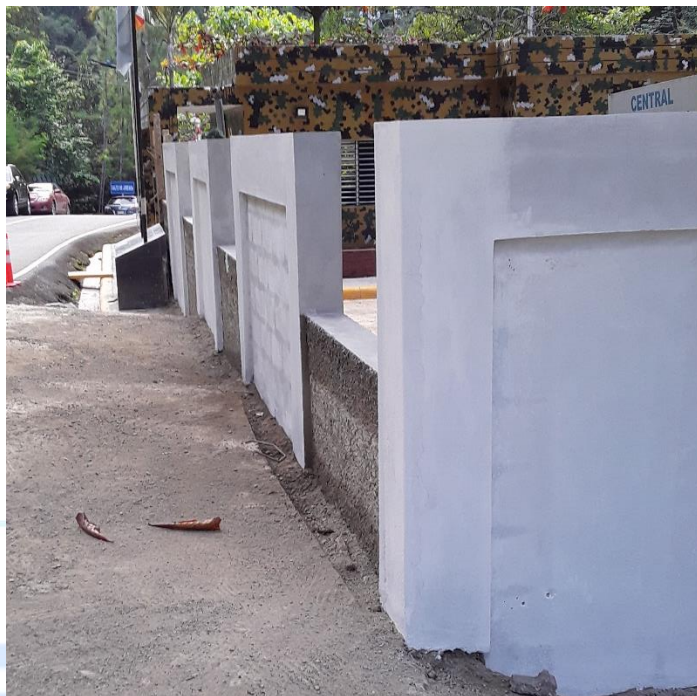
Aplicación pintura base en verja frontal, Campamento Jimenoa.
