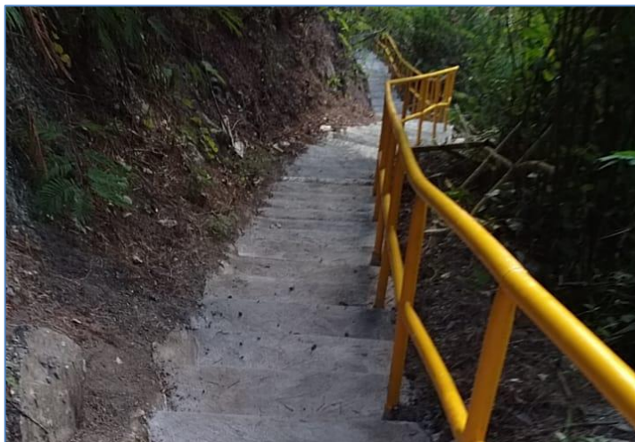
Construcción de escalones presa de Jimenoa, Campamento Jimenoa.
