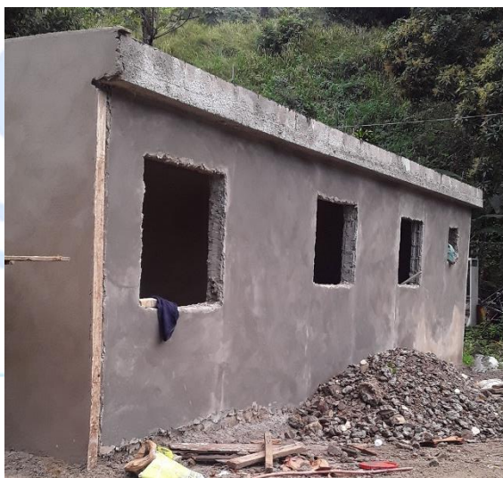
Colocación de pañete en casas, Campamento Jimenoa.
