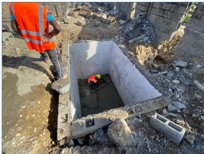
Pañete en muros de la cisterna, Destacamento Cambita.
