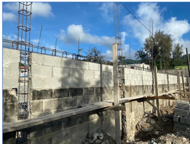
Colocación de acero de refuerzo en viga de amarre en muro perimetral, Destacamento Cambita.
