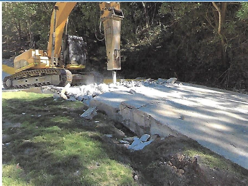
Demolición losa baden de acceso a presa
