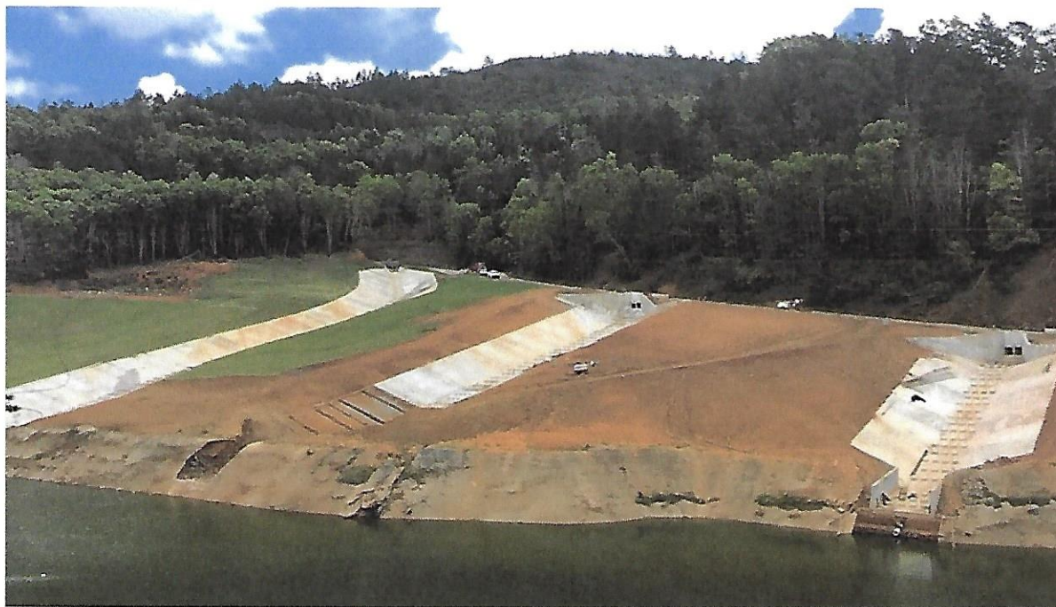
Fotos de parte de los trabajos de estabilización.
