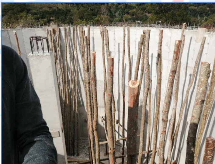
Encofrado etapa final tanque de 500 m 3 Iguana abajo, Acueducto Montería.
