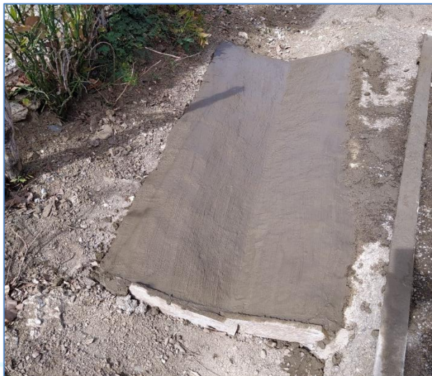
Cunetas de hormigón simple, Acueducto Montería.
