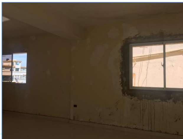
Instalación de ventanas, Iglesia Santa Lucía.
