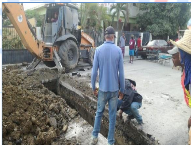
Excavación para construcción de verja perimetral, Iglesia Santa Lucía.
