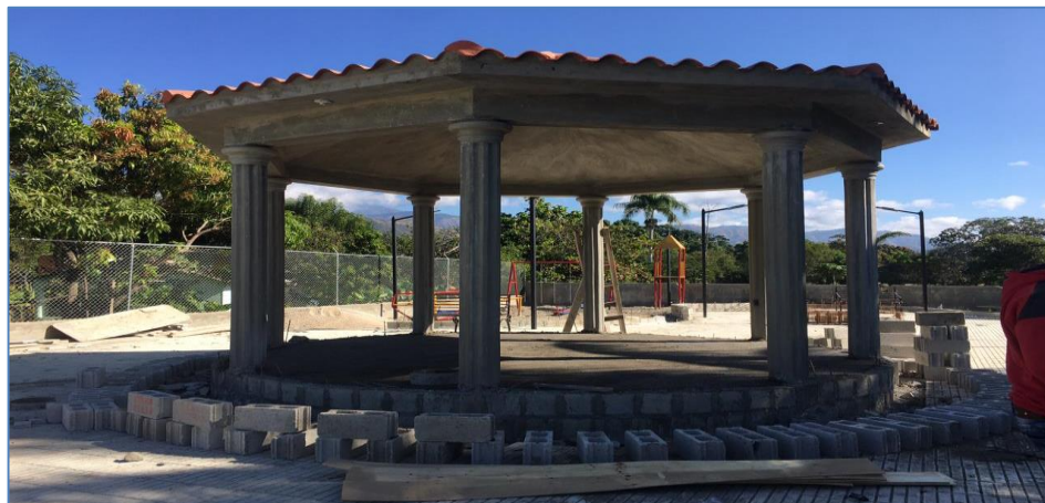
Vaciado de torta escalones en glorieta, Parque en el Batey.
