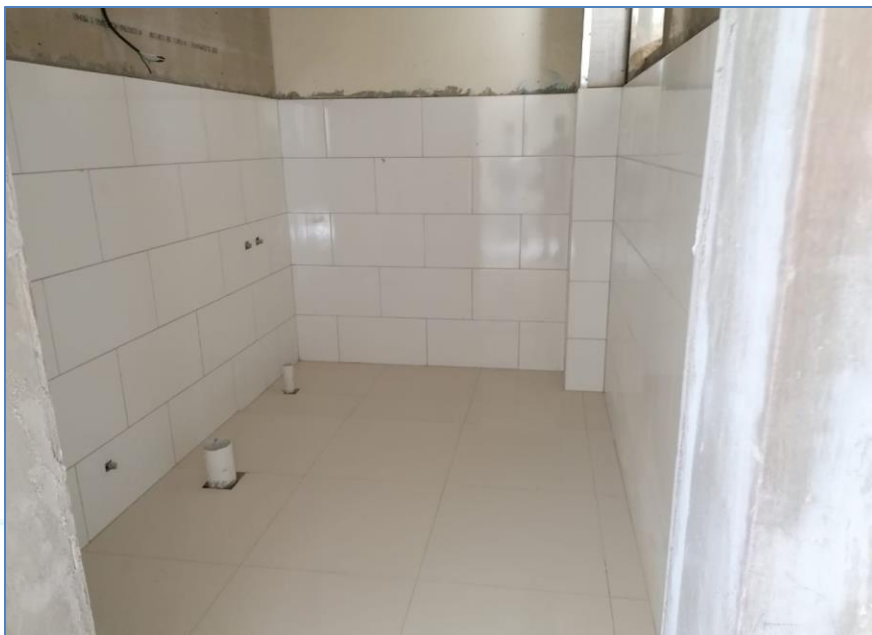
Revestimientos y Cerámica en baños, Iglesia Santa Lucía.
