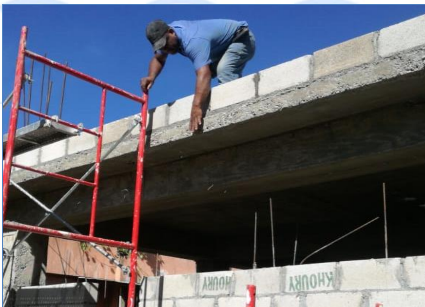
Colocación de bloques en antepecho del salón parroquial, Iglesia Santa Lucía.
