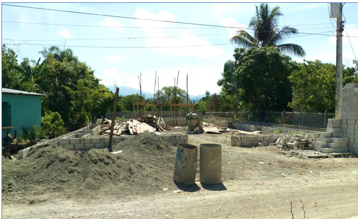
Vaciado de columnas en la Glorieta, Parque en el Batey.
