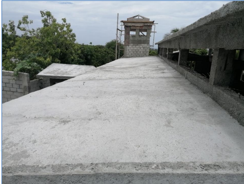
Vaciado de fino en losa lateral derecha, Iglesia Perpetuo Socorro.
