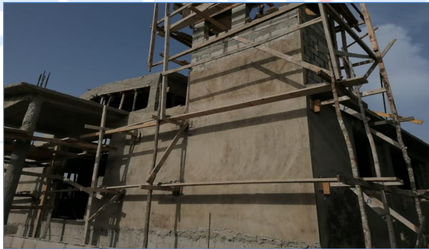
Colocación de pañete exterior en campanario, Iglesia Perpetuo Socorro.
