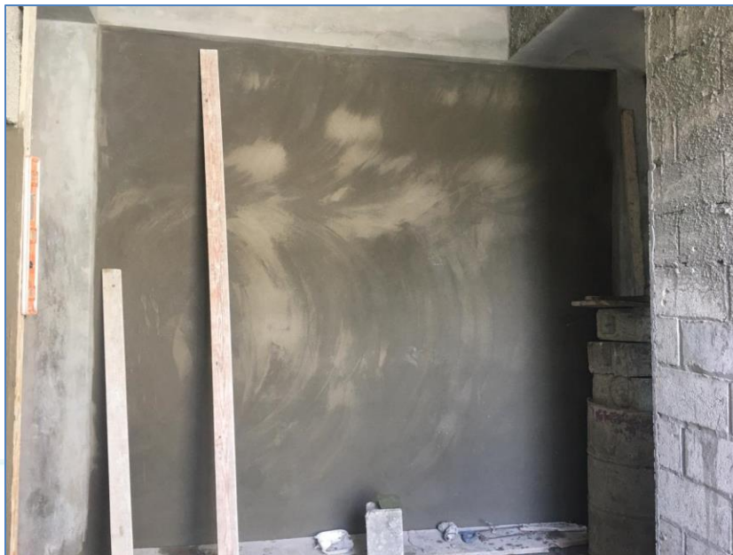
Colocación de pañete en segundo nivel, Alcaldía Juan de Herrera.
