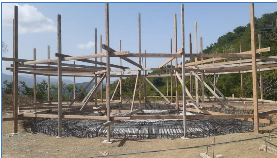
Colocación de acero Tanque Buena Vista y Arroyo Salado, Acueducto Montería.
