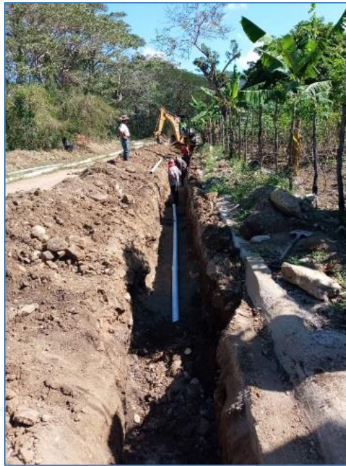
Línea de Impulsión Iguana, Acueducto Montería.
