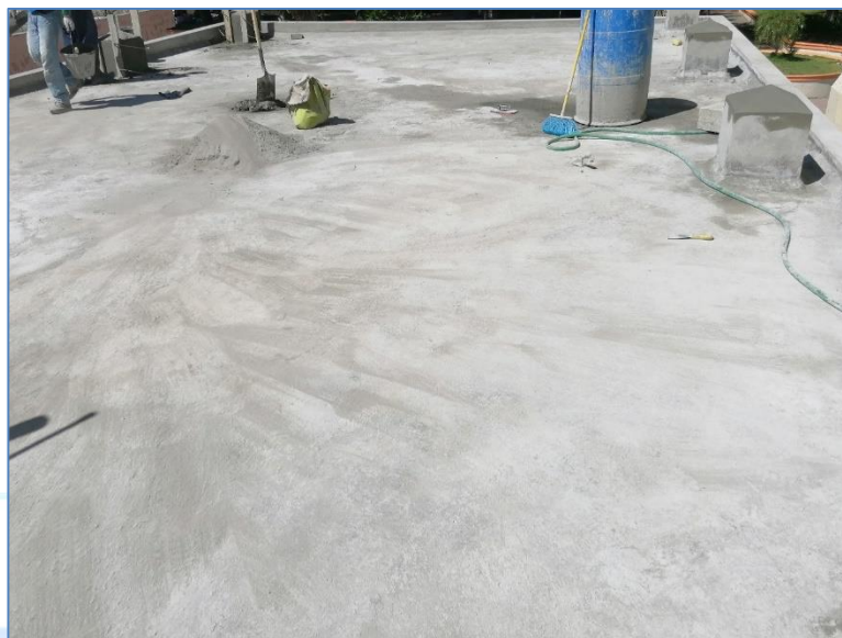
Colocación de fino de techo en salón parroquial, Iglesia Santa Lucía.
