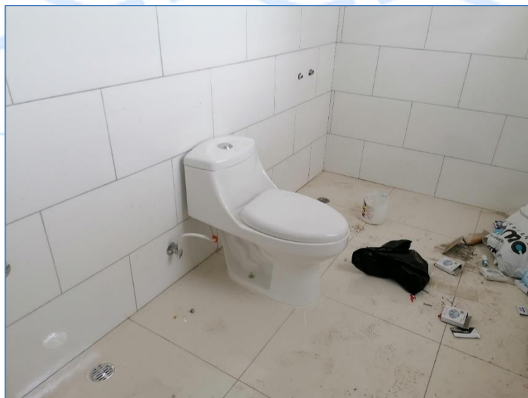
Colocación de inodoros en baños segundo nivel, Iglesia Santa Lucía.
