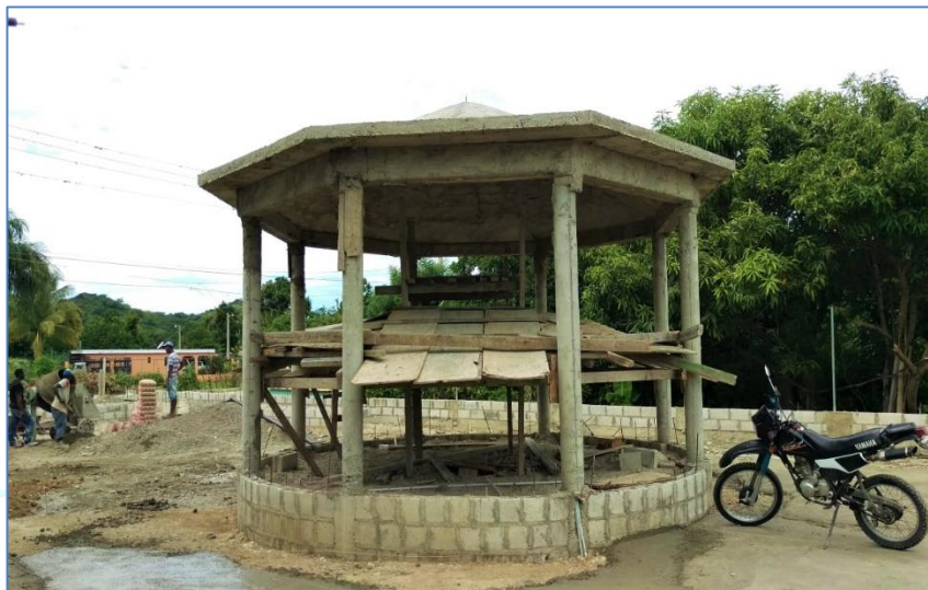
Desencofrado de losa de techo en glorieta, Parque en el Batey.
