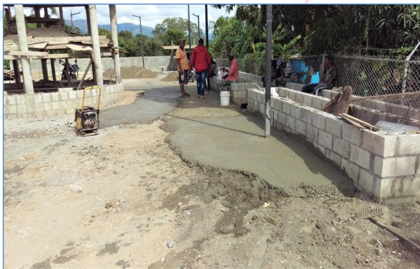
Vaciado de torta de piso en hormigón, Parque en el Batey.
