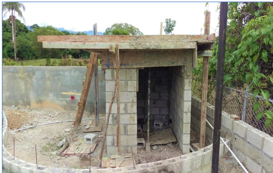
Vaciado de losa de hormigón en caseta, Parque en el Batey.
