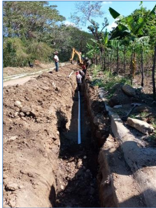
Línea de Impulsión Iguana, Acueducto Montería.
