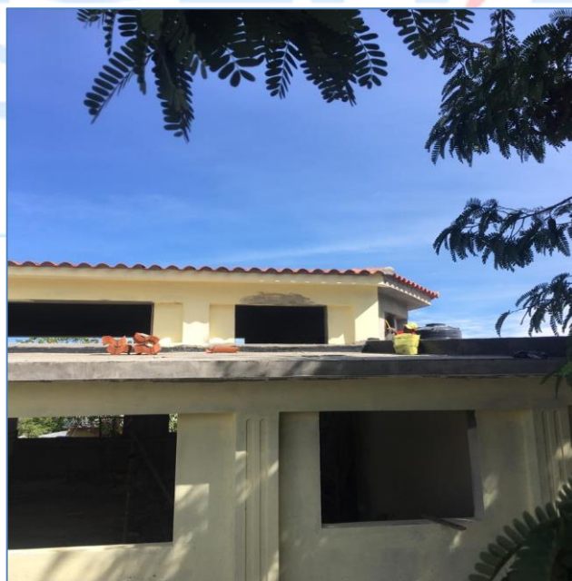
Aplicación de pintura exterior, Iglesia Perpetuo Socorro.
