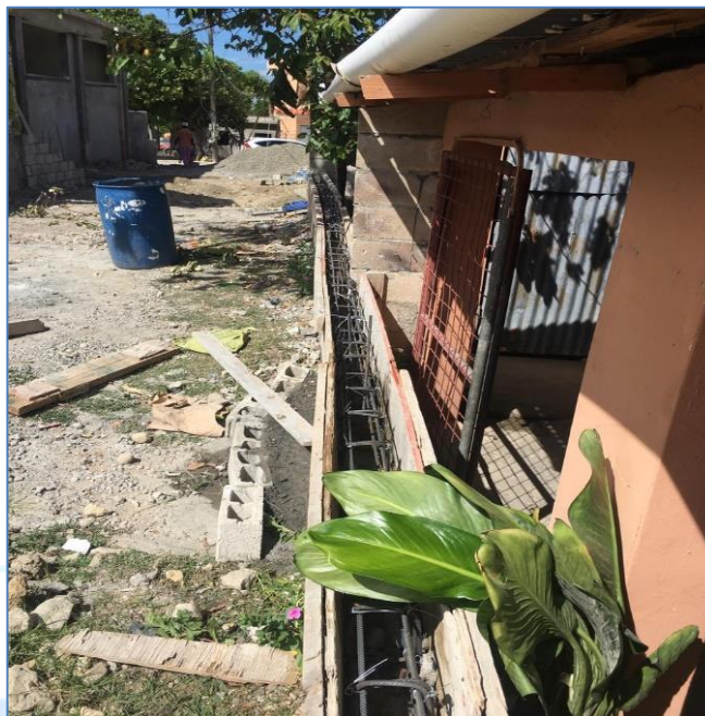
Vaciado de viga en verja perimetral, Iglesia Perpetuo Socorro.
