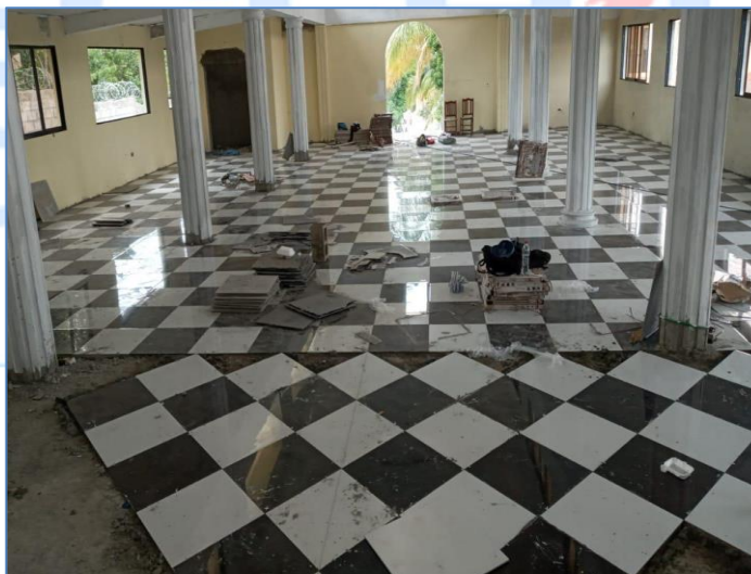
Colocación de cerámica de piso en templo, Iglesia Perpetuo Socorro.
