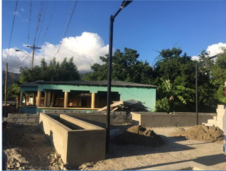
Colocación de pañete en jardineras, Parque en el Batey.
