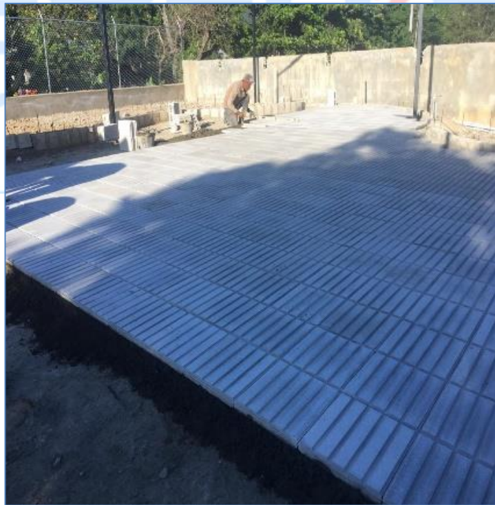
Colocación de torcho en área de parque, Parque en el Batey.
