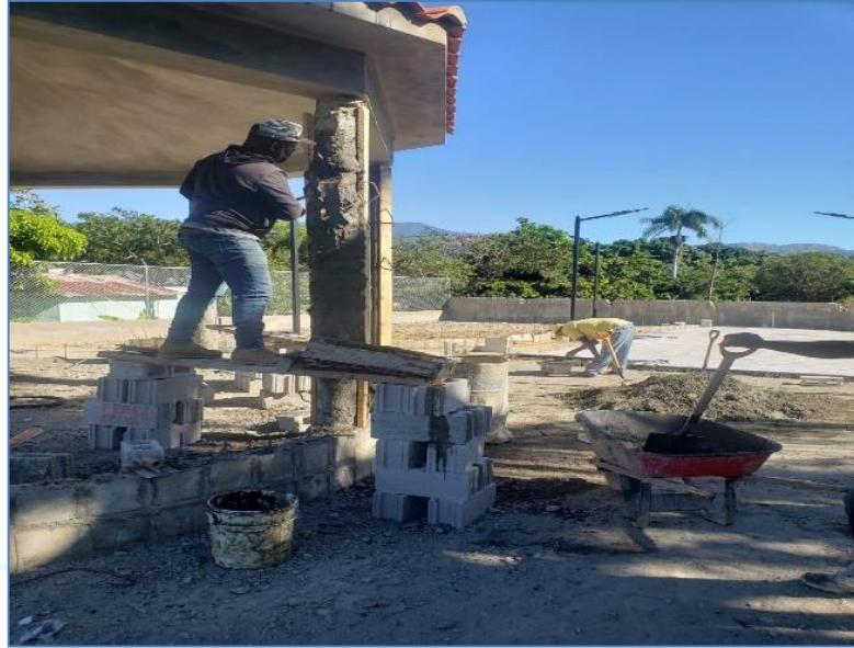
Colocación de pañete en columnas de la glorieta, Parque en el Batey.
