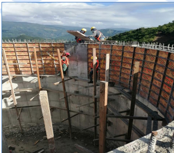
Desencofrado interior tanque Los Jobitos, Acueducto Montería.
