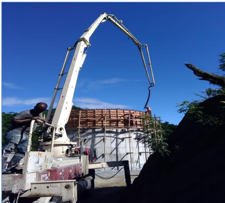
Vaciado final Tanque Los Jobitos, Acueducto Montería.
