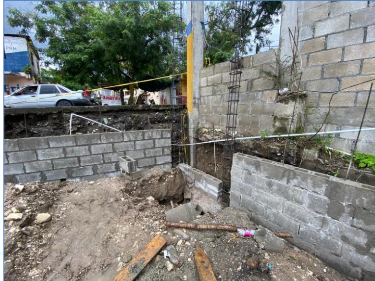
Colocación de bloques hasta nivel de viga de amarre, Destacamento Cambita.
