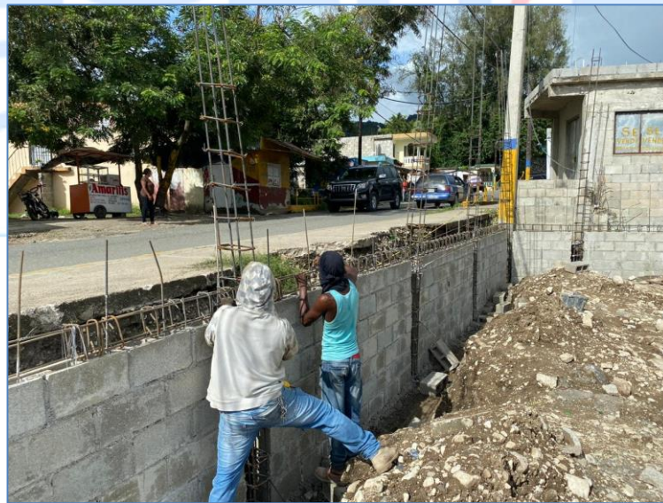
Colocación de acero en viga de amarre, Destacamento Cambita.
