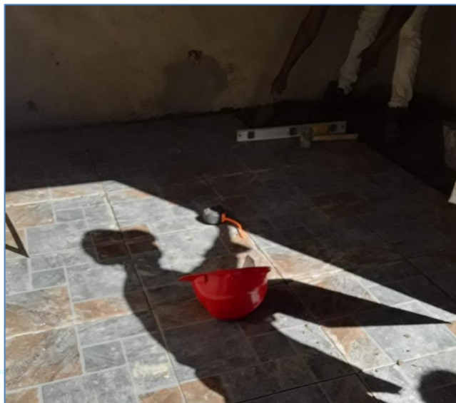
Colocación de cerámica de pisos caseta de tóxicos, Campamento Jimenoa.
