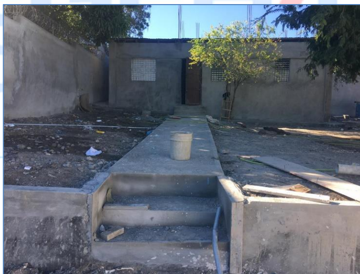
Construcción de acera hacia caseta, Iglesia Perpetuo Socorro.
