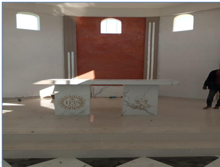
Construcción del altar, Iglesia Perpetuo Socorro.
