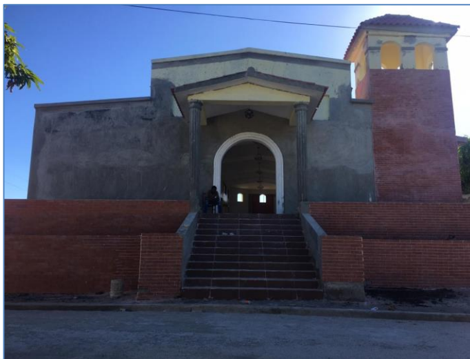
Construcción de escalones escalera frontal y revestimientos en ladrillos en fachada, Iglesia Perpetuo Socorro.
