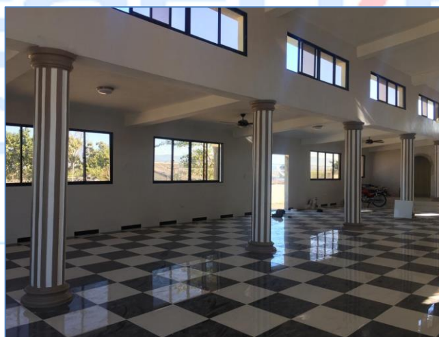
Aplicación de pintura en columnas, Iglesia Perpetuo Socorro.
