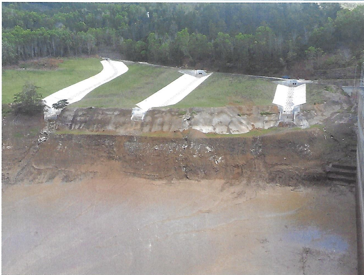
Fotos de parte de los trabajos de estabilización.
