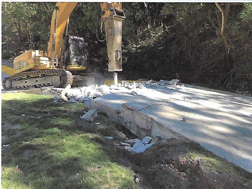
Demolición losa baden de acceso a presa
