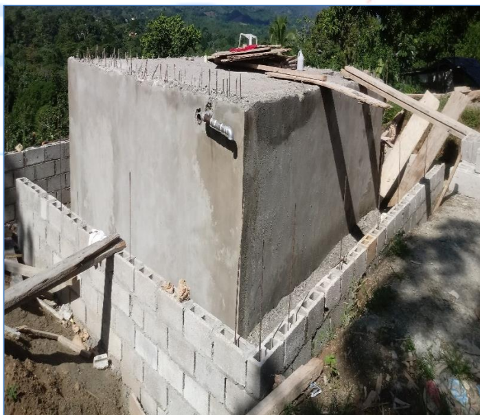
Vaciado de muros de tanque La Cuchilla, Solución Agua Potable Vista Hermosa.
