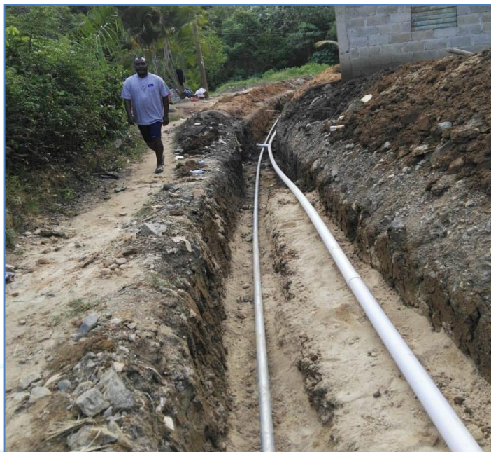
Colocación de tuberías en líneas de impulsión y distribución, Solución Agua Potable Vista Hermosa.
