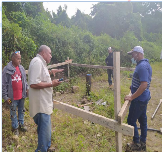
Charrancho para replanteo de plataforma de pozo, Acueducto Montería.
