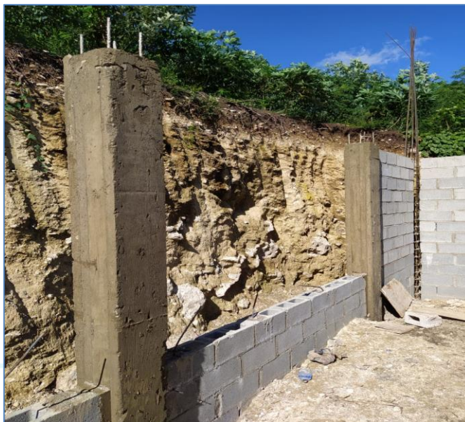
Columnas vaciadas en verja perimetral del tanque de Iguana, Acueducto Montería.
