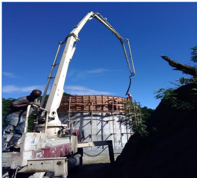
Vaciado final Tanque Los Jobitos, Acueducto Montería.
