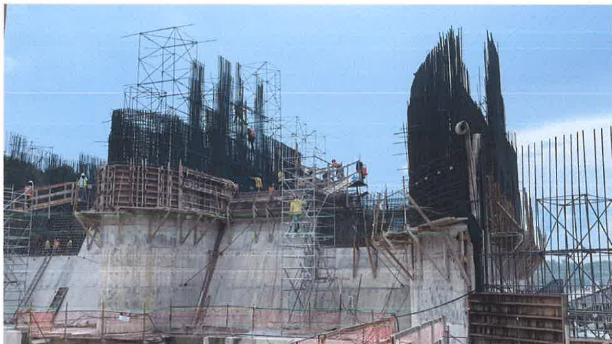
Foto Presa Boca de los Ríos (Presa del Rio Guayubín)
