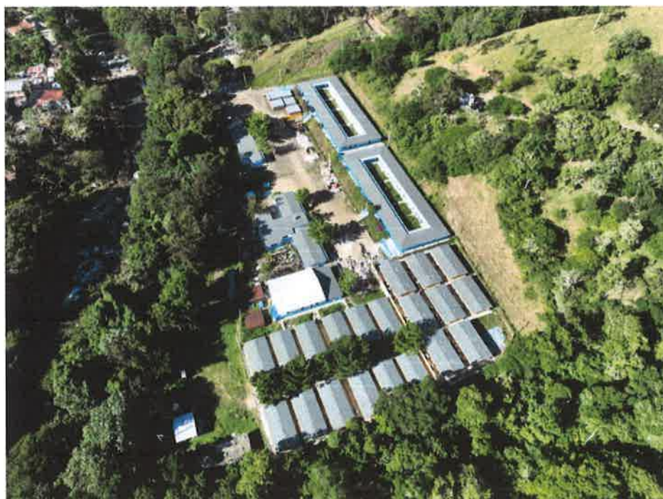
Rehabilitación Campamento el Higuero
