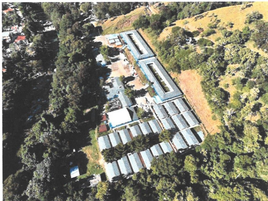
Rehabilitación Campamento el Higuero
