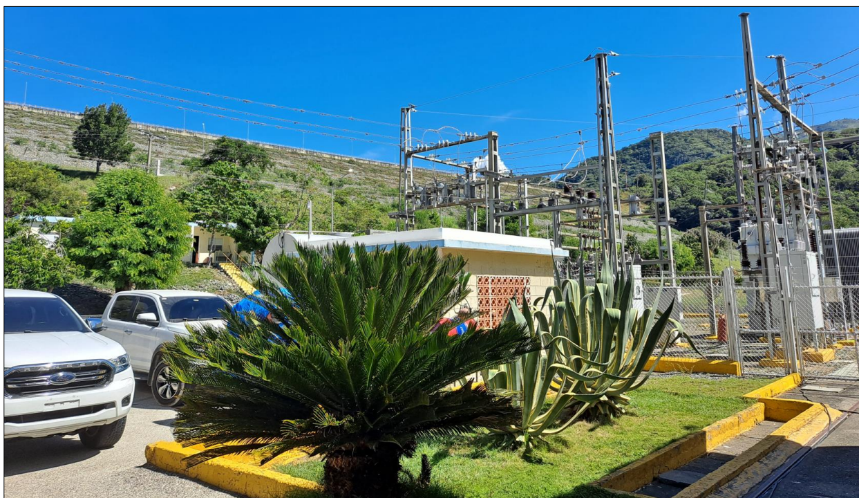
Figura Nº 1. Vista desde aguas abajo de la presa de Sabaneta y parte de sus instalaciones
