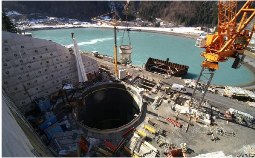
Figura N° 1. Ejemplo de excavación de plataforma
