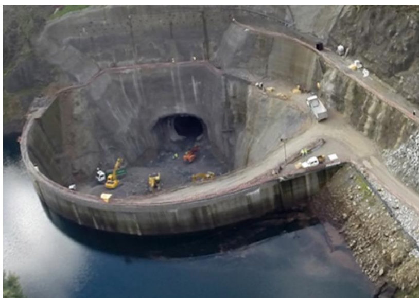
Figura N° 20. Ejemplo de construcción de atagüía
