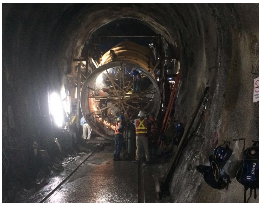
Figura N° 17. Ejemplo de montaje y hormigonado de codo de la forzada
