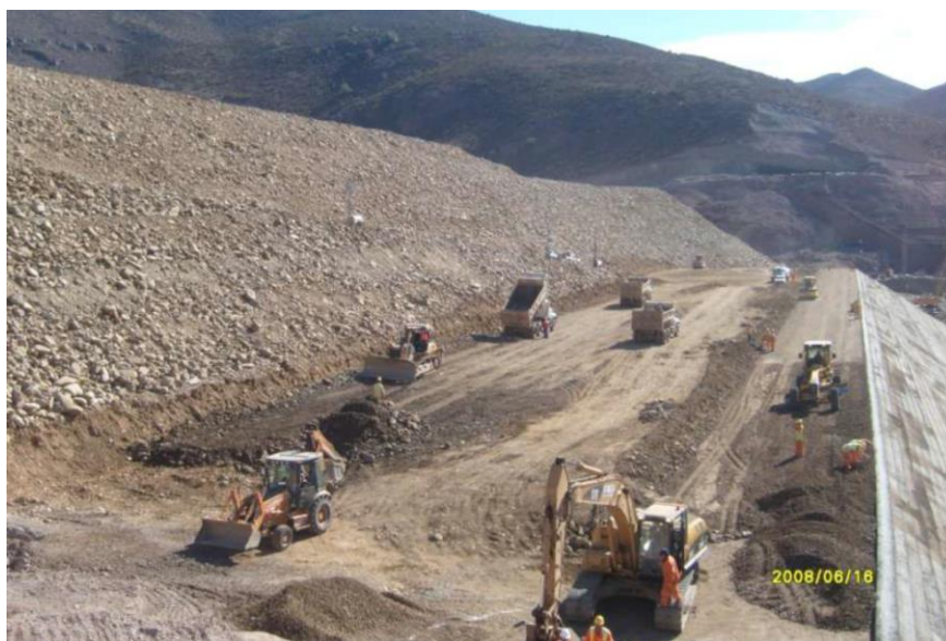
Figura N° 10. Ejemplo de construcción de dique
