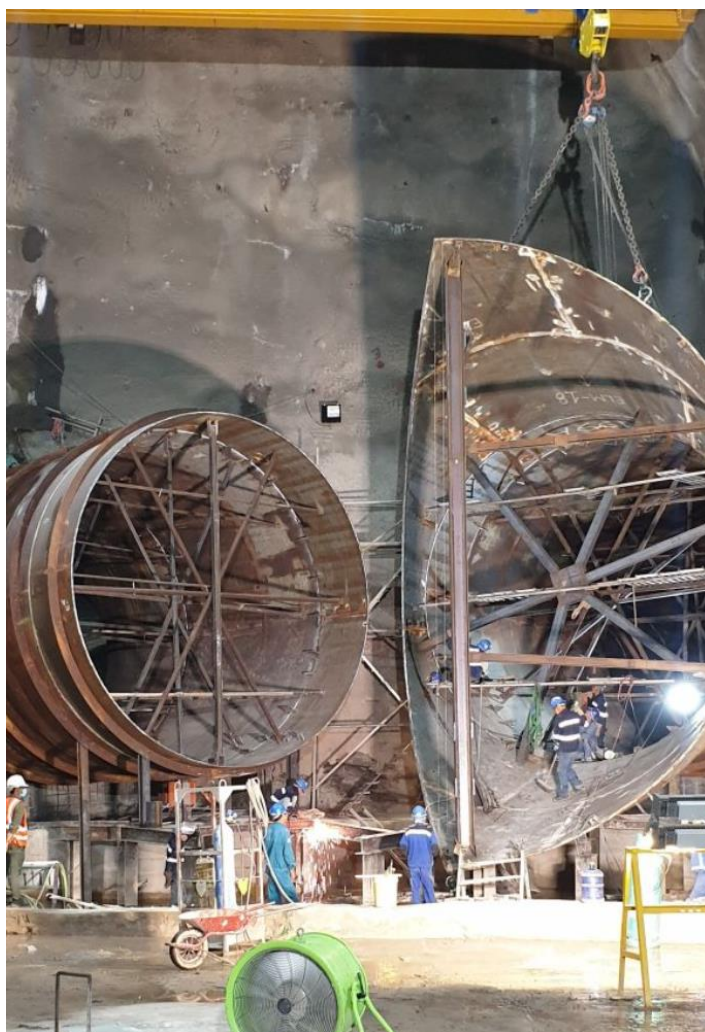
Figura N° 18. Ejemplo de montaje y hormigonado de distribuidores hidráulicos
