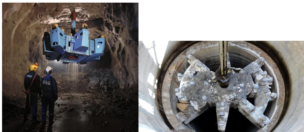
Figura N° 14. Ejemplo de trabajos de excavación de pozos mediante Raise Boring
