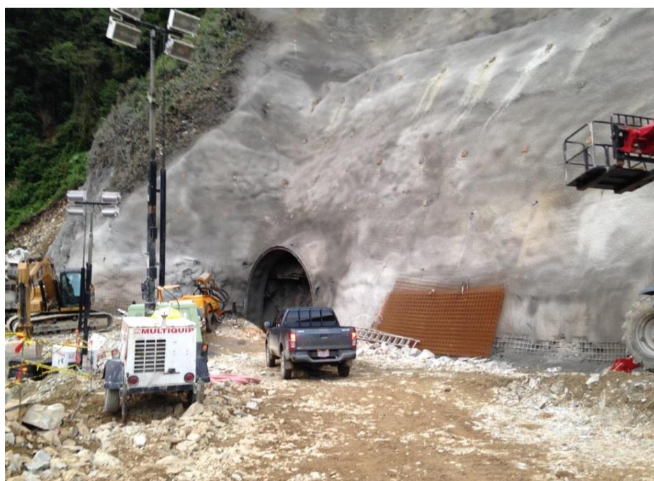
Figura Nº 4. Ejemplo de excavación de trinchera para emboquille de túneles
