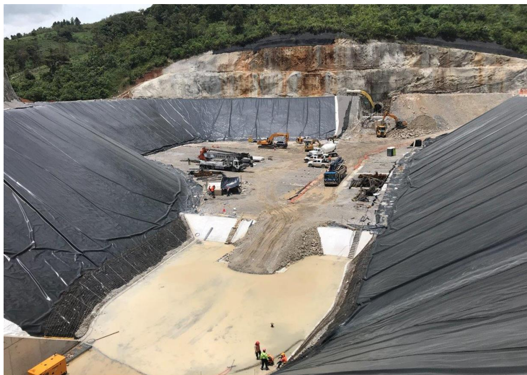
Figura Nº 13. Ejemplo de trabajos de impermeabilización de depósito
