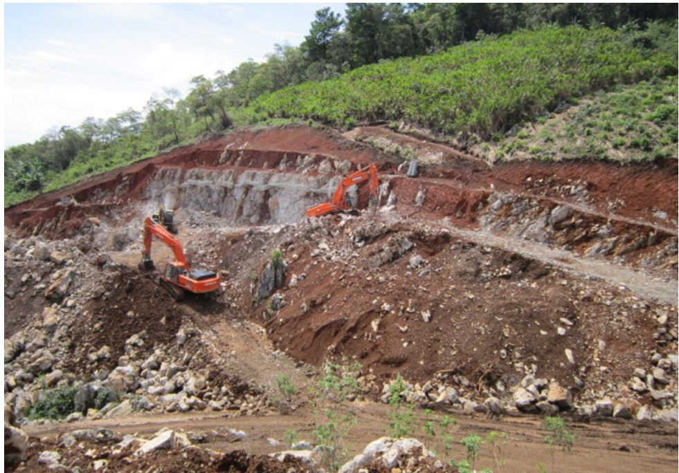
Figura N° 2. Ejemplo de excavación de depósito (1)
