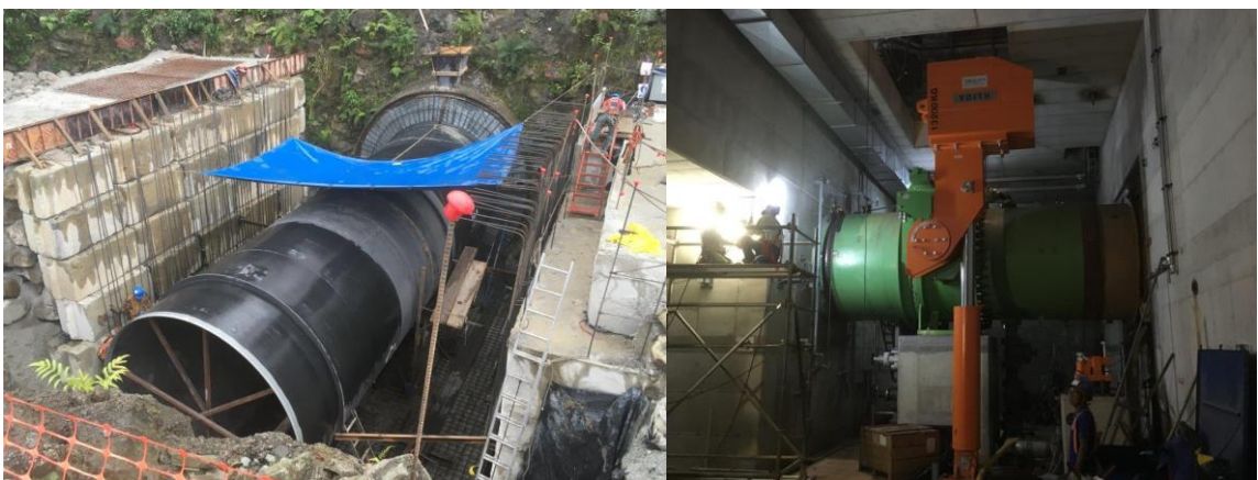
Figura N° 9. Ejemplo de montaje de válvula mariposa
