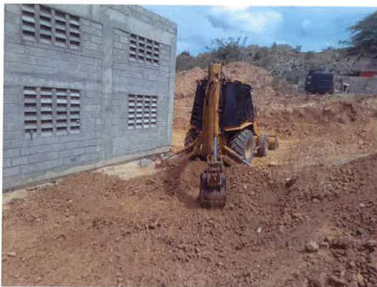
Inicio de excavaciones de zapata de verja perimetral del Carcamo de Bimbeo
