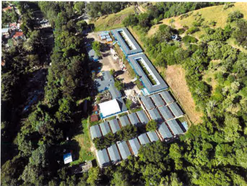
Rehabilitación Campamento el Higuero
