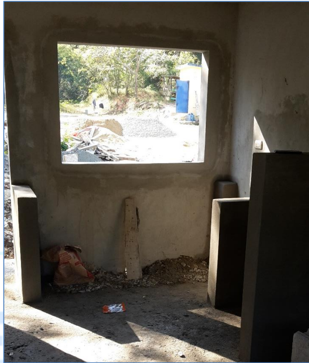
Construcción de muros en cocina para soporte de meseta, Cuartel Militar Bao.
