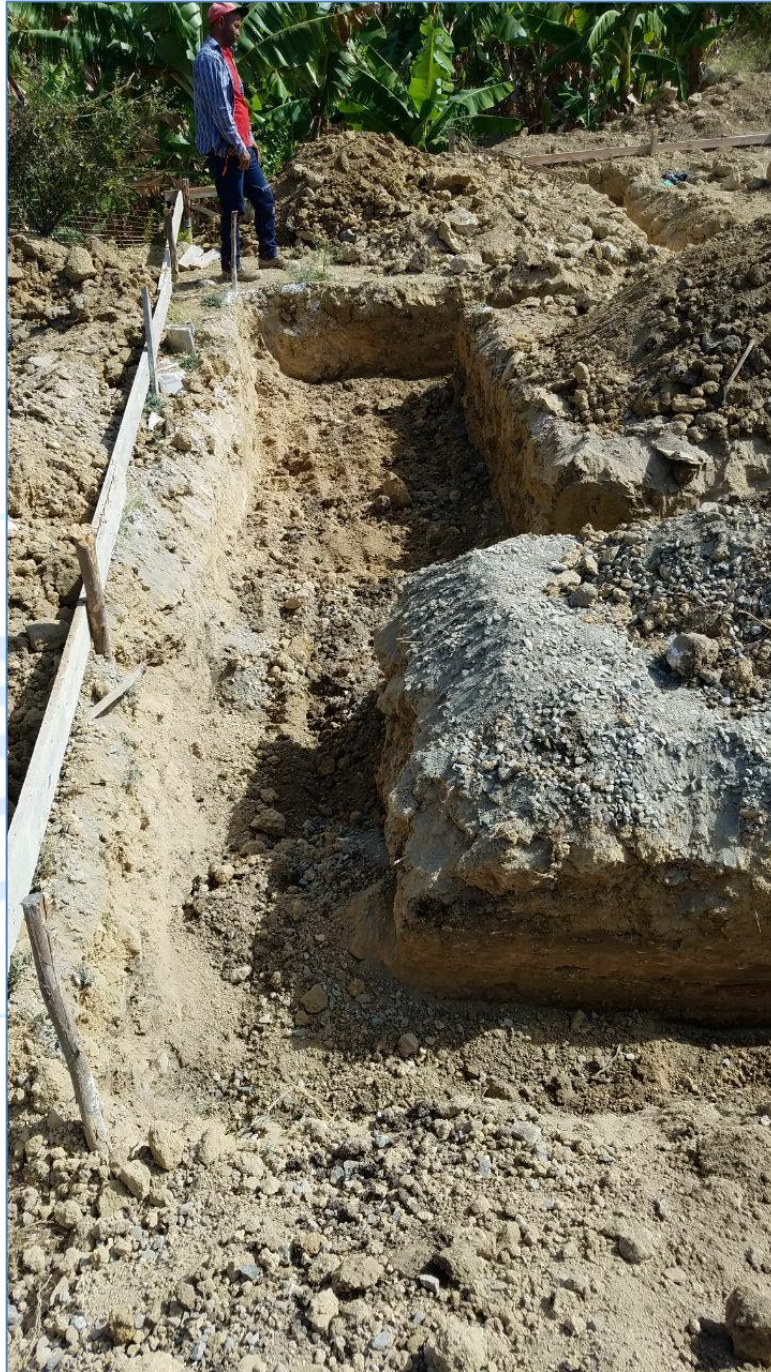
Excavación de zapatas caseta del generador y garita, Acueducto Sabaneta.
