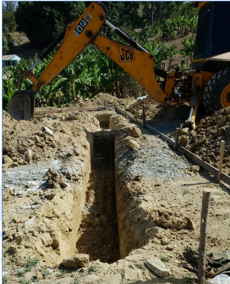
Excavación de zapatas caseta del generador y garita, Acueducto Sabaneta.
