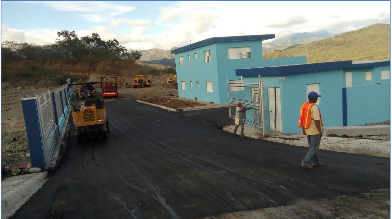
Colocación del asfaltado, Relleno Sanitario Bohechío.
