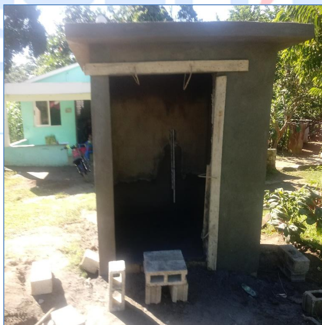
Construcción de caseta para arrancador de la bomba, Solución Agua Potable Vista Hermosa.
